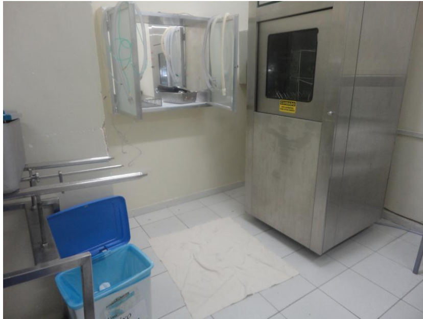
Figura 26: Janela de comunicação da área suja com a área limpa e lixeira para descarte de resíduos comuns, com acionamento por pedal
