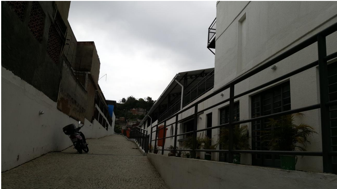
Figura 21 - Rampa na entrada da Casa do Jongo. Registrado pela autora (janeiro/2017).
