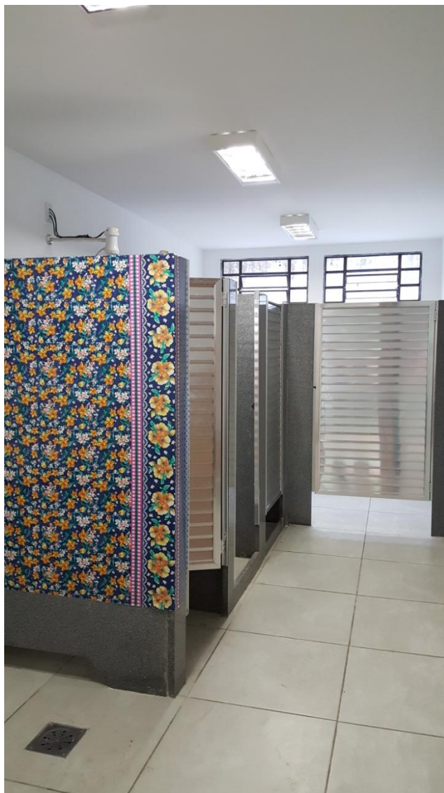
Figura 22 - Banheiro com acessibilidade na Casa do Jongo. Registrado pela autora (janeiro/2017).
