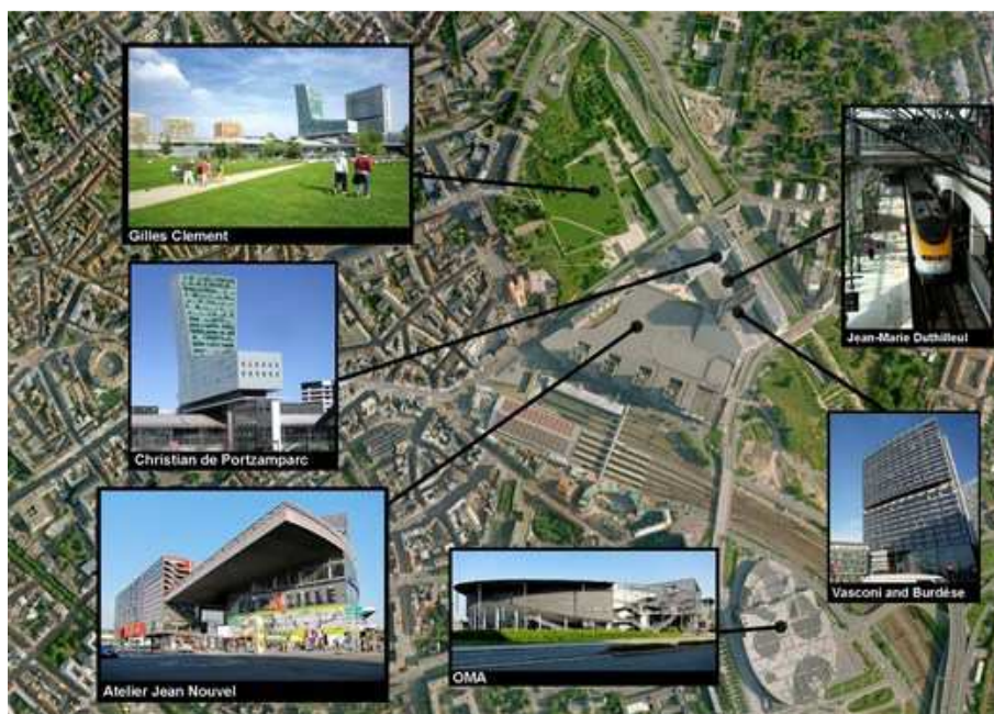
Fig. 12 – Área do projeto urbano Euralille, com os diversos escritórios de arquitetura que participaram da readequação urbana, entre eles o OMA, escritório de Koolhaas. [1994]. Fonte: http://www.oma.eu/projects/1994/eurailille/
