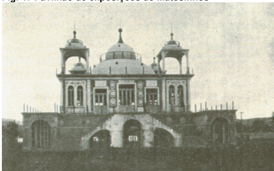
Fig. 47 Pavilhão de exposições de Matosinhos
