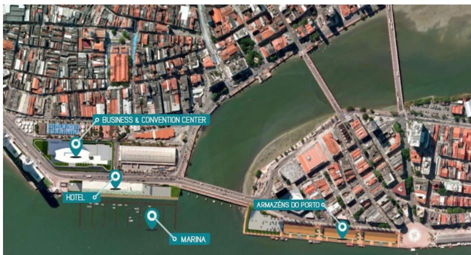
Foto 8 – Bairro do Recife – localização das obras do Porto Novo Recife
