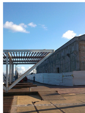
Foto 11- Armazém em construção Fonte: Foto Carla Lyra
