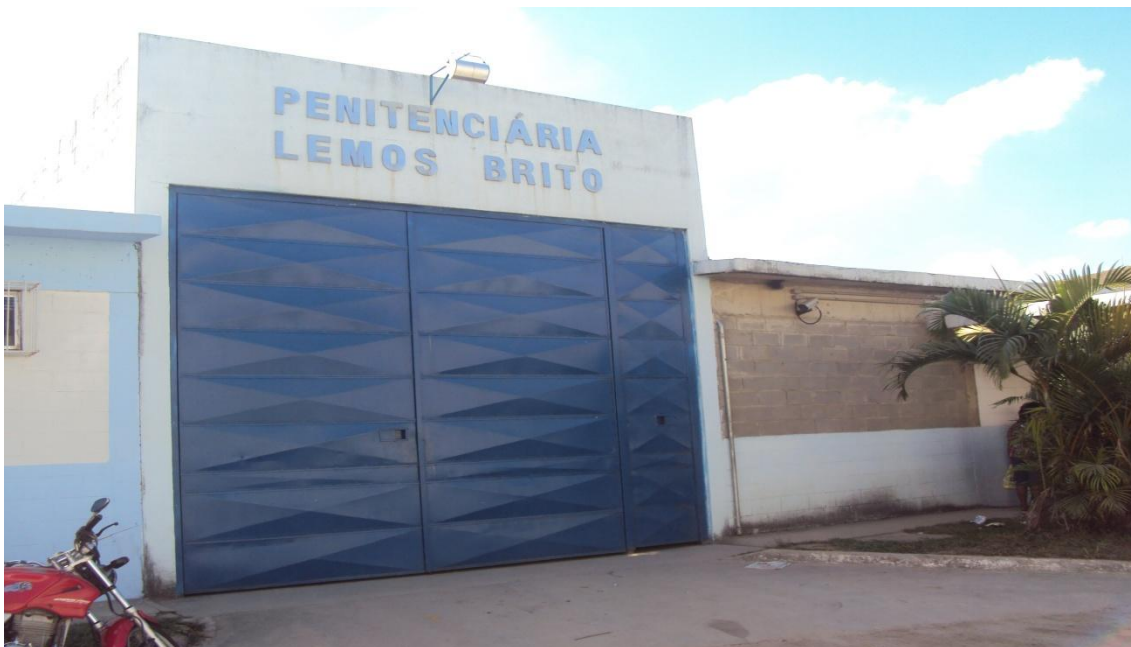
Fachada Unidade Prisional Lemos Brito, Complexo Gericinó, Bangu, Rio de Janeiro
