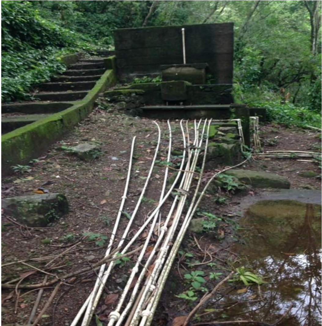
Figura XIV - Caixa de armazenamento de água da Sociedade Boa Vista (foto Bárbara Pelacani)
