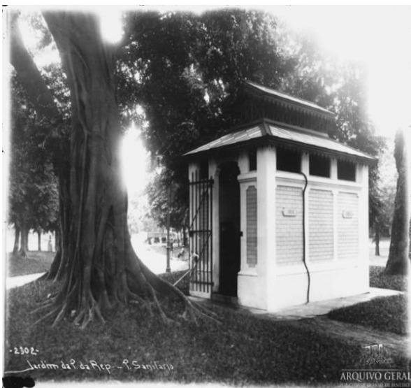
Fac-símile n.º 26: Pavilhão Sanitário no Jardim da Praça da República Fonte: Arquivo Geral da cidade do Rio de Janeiro.
