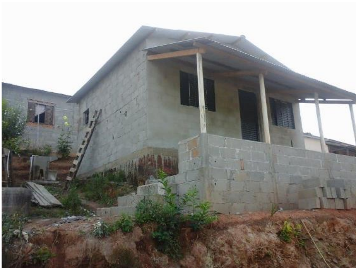
Foto 4: Porta da sala com varanda, que antes não existia na casa da Gracinha
