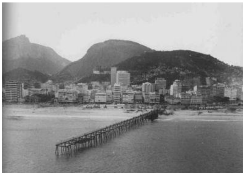
FOTO 3 – píer construído em Ipanema, 1972
