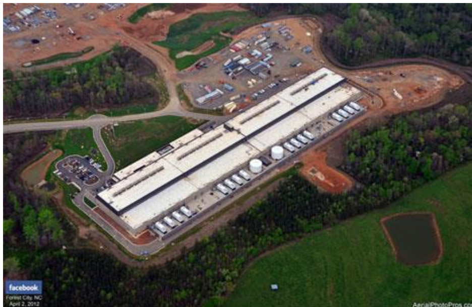
Figura 1 – Fazenda de servidores 19 do Facebook , em Forest City, North Carolina Fonte: http://www.datacenterknowledge.com/the-facebook-data-center-faq/
