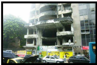
112. Prédio do Cine Plaza abandonado, 2009 (Fonte: Rio de Janeiro que eu amo)
