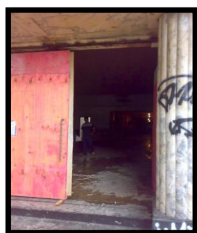
135. Obras no Palácio, 2012 (Fonte: Skyscrapercity)
