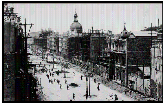
15. Avenida Central em construção, 1905, foto de João Martins Torres. (Fonte: BeiComunicação, 2005)
