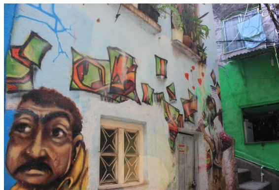
Figura 44 Casa-Tela 16 antes da restauração 2. Fotografia: Sarah Braga, 2014.
