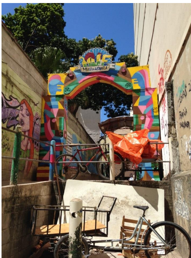
Figura 26 Portal do Amor Perfeito depois da restauração. Fotografia: Fernanda Rodrigues, 2014.
