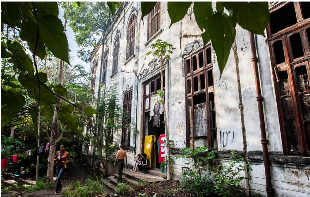
Figura 10: área externa do casarão
