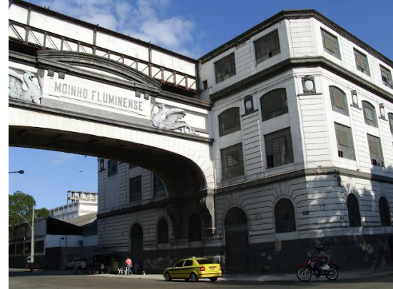
Figura 08 – Moinho Fluminense. - Fonte: https://picasaweb.google.com/105022776054359315180/SaudePortoMaravilhaRJ#5618904740996967746 Acesso em 23 jan. 2012
