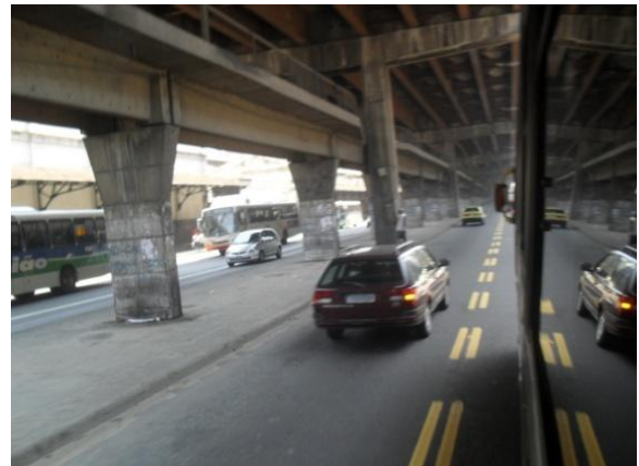
Figura 15 - Perimetral – Av. Rodrigues Alves Fonte: www.skyscrapercity.com . Acesso em 21 jun. 2010
