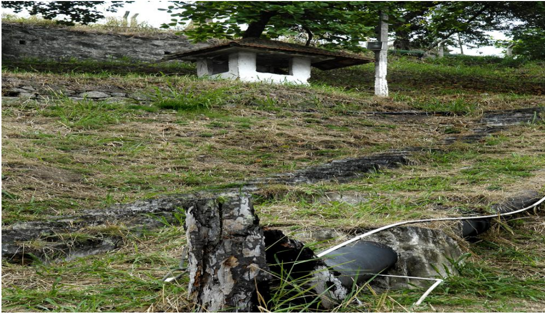
Figura 7 - Guarita do Presídio Edgard Costa. Esta guarita permite uma visão de 180° da área em que os presos realizam atividades laborativas. Foto de agosto de 2011 - de Renzo Gostoli.
