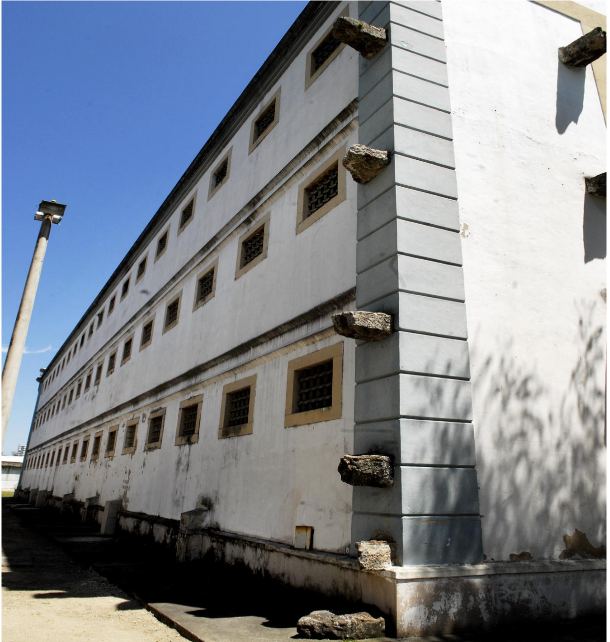
Figura 14 – Lateral externa esquerda do Instituto Penal Vieira Ferreira Neto. As imensas pedras encaixadas nas paredes possibilitariam a continuidade de construção de outros pavimentos do prédio, como hoje se utiliza as armações (esteiras) de ferro (vergalhões). Foto de setembro de 2011 - de Renzo Gostoli.
