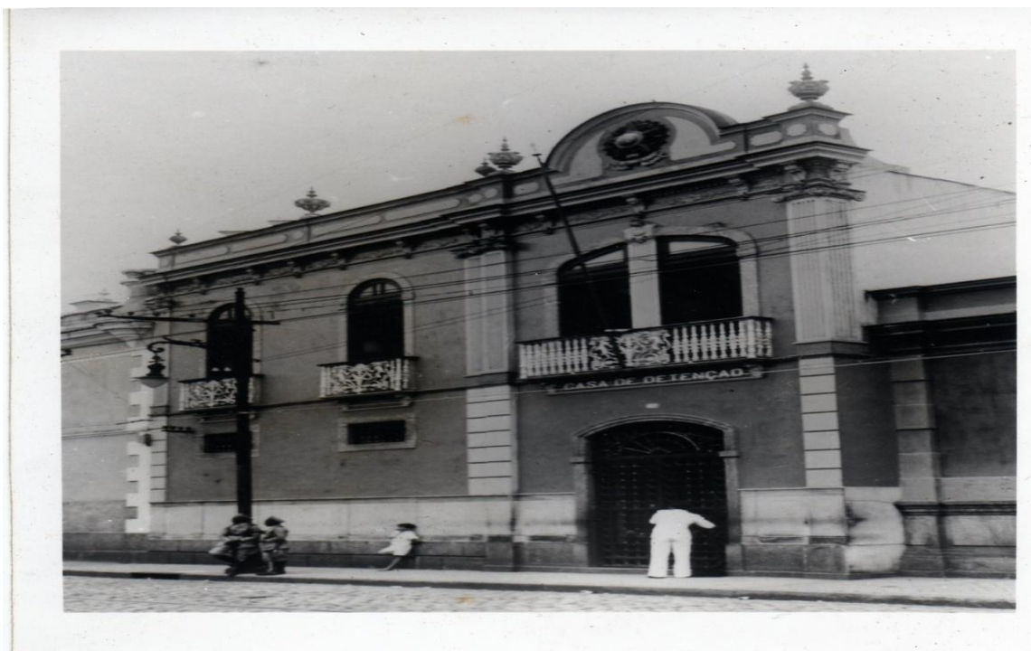
Figura 15 – Fachada da Casa de Detenção – Foto cedida pela EGP/SEAP.
