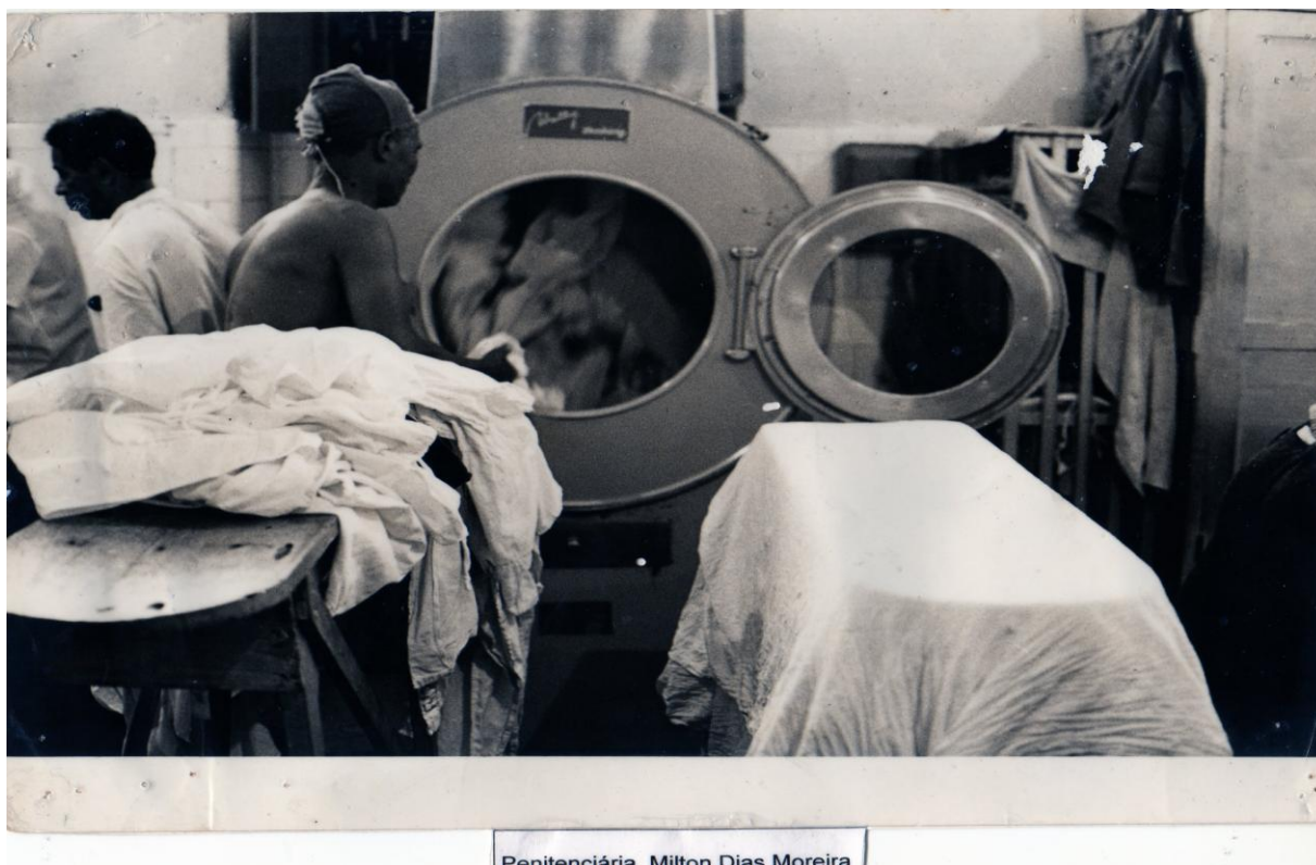
Figura 29 - Lavanderia, já existente na época do Presídio do Distrito Federal, conforme informamos no processo anterior. Fotografia cedida pela EGP/SEAP.
