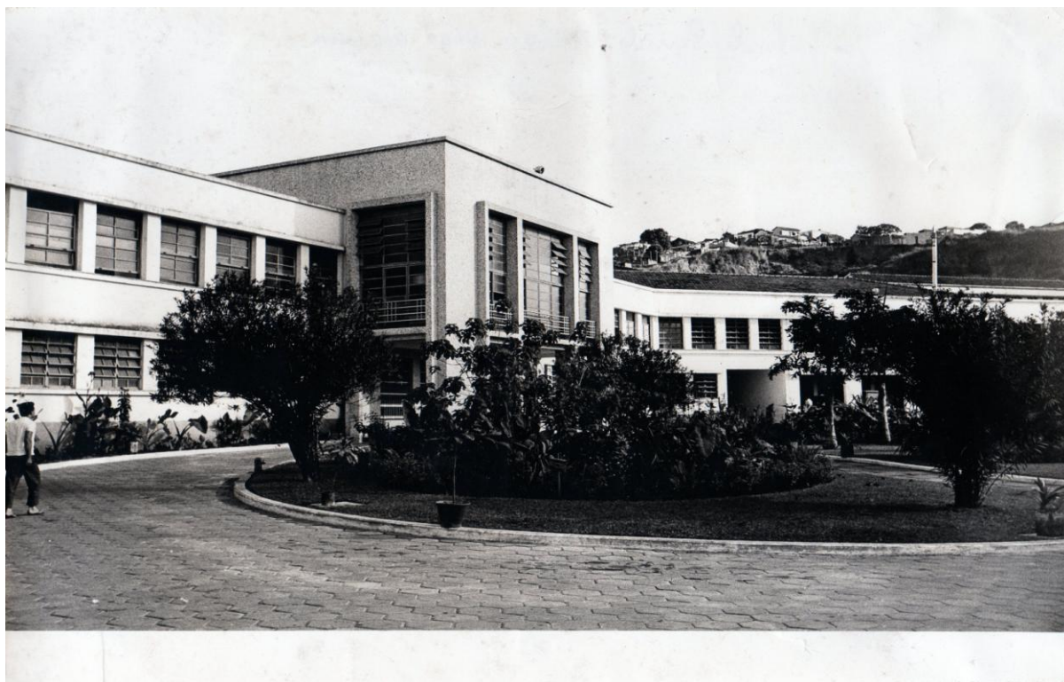
Figura 31 - Fachada da portaria e da área da administração do Presídio do Distrito Federal após as obras da década de 1940. Fotografia cedida pela EGP/SEAP.
