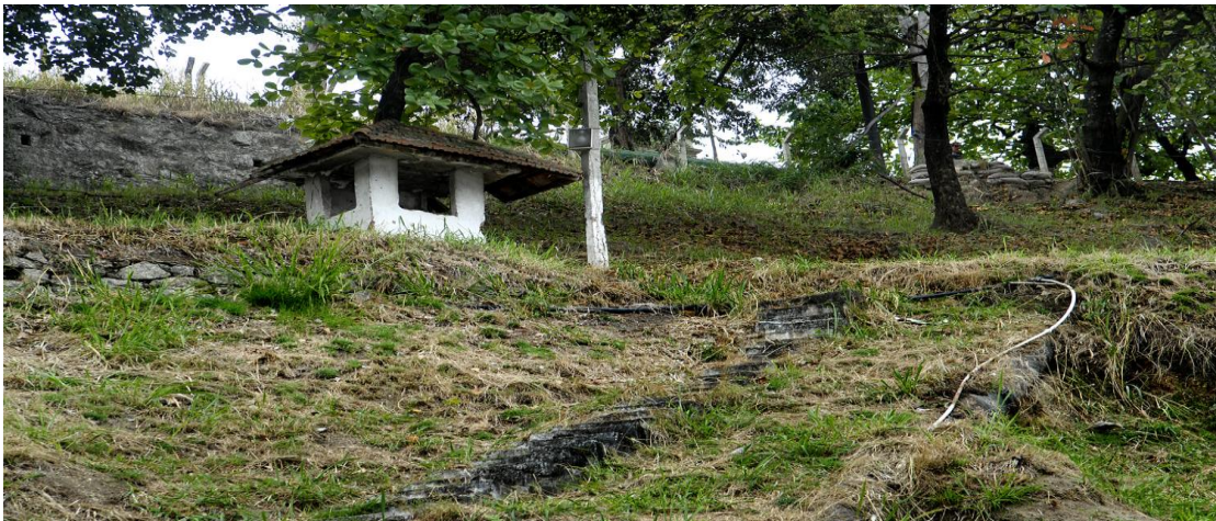
Figura 5 – Fundos do Presídio Edgard Costa em Niterói, que teve parte do terreno desmoronado no século XIX, para permitir a construção da prisão. Foto de agosto de 2011 - de Renzo Gostoli.
