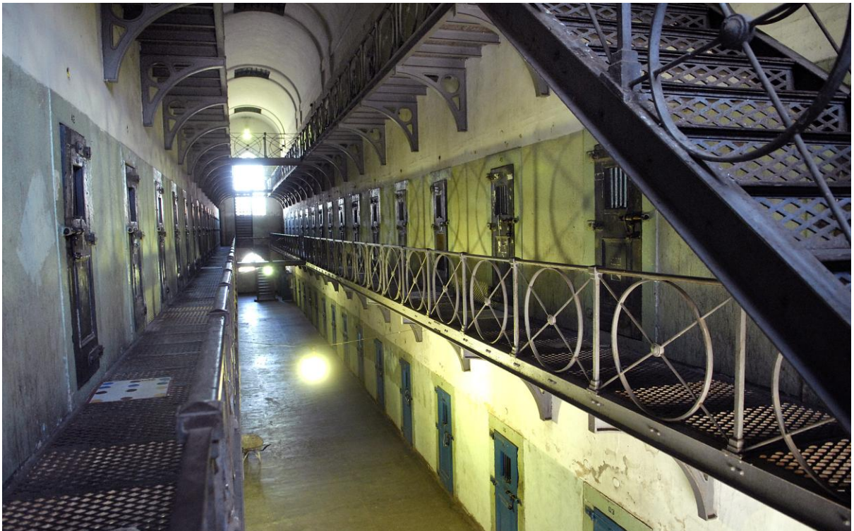
Figura 9 – Instituto Penal Vieira Ferreira Neto – Construção do século XIX que seguiu o modelo do regime de isolamento celular de Filadélfia e, a laminação do tipo francesa no trabalho com escadas e corredores em ferro fundido, que persistem há mais de um século. Foto de setembro de 2011- de Renzo Gostoli.
