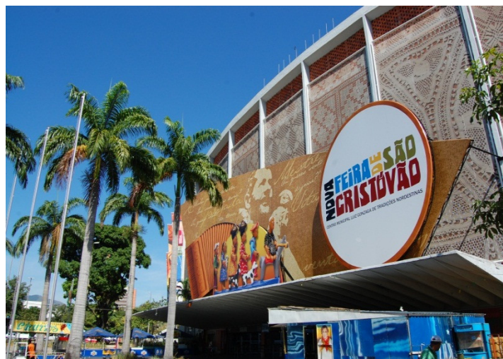
Figura 20: Mesma fachada, após reforma de 2012. Elementos espetacularizados da “cultura nordestina” em maior quantidade. 26 de fevereiro de 2012. Foto: Vitor Rebello.
