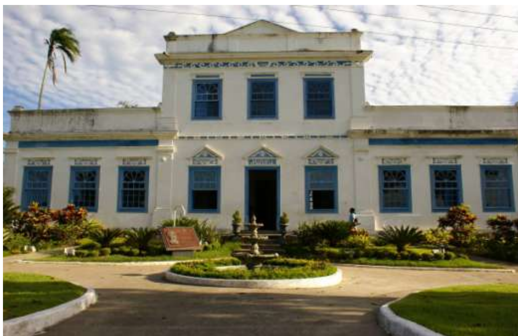
Figura 7 - Prédio do Museu Arqueológico de Araruama
