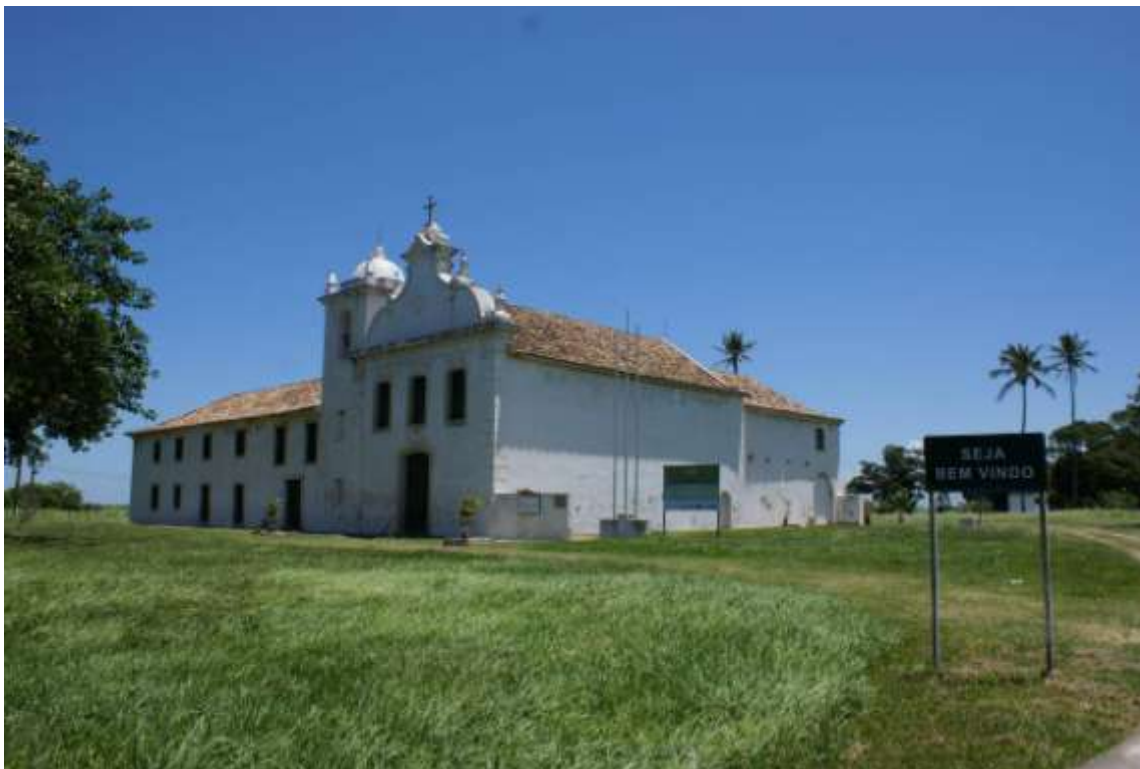
Figura 4 - Prédio e Terreno do Solar do Colégio
