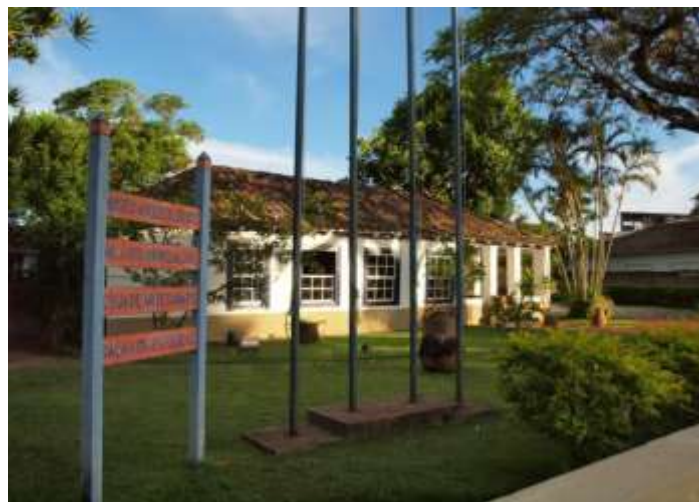
Figura 12 - Casa de Cultura Bento Costa Júnior (vista lateral esquerda) 38
