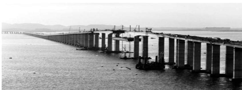
Montagem do vão central da Ponte Rio - Niterói. Foto de 1974 8 .
