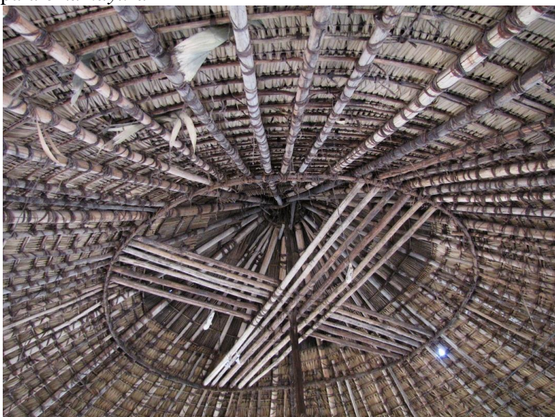
Foto 45 – Vista interna do telhado coberto da tamiriki “modelo waiwai”. Destaque no centro para o kamayura
