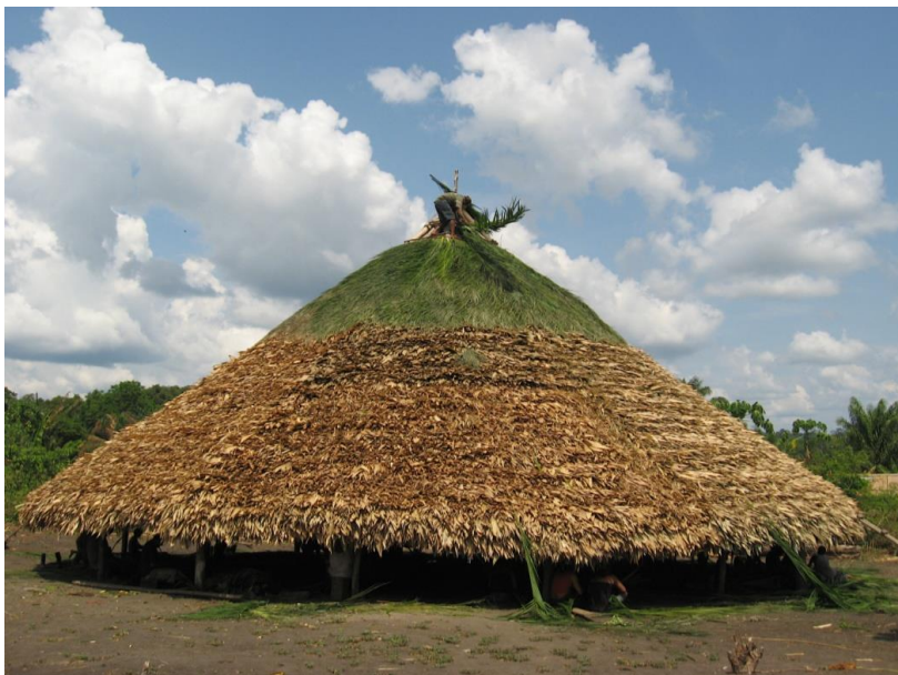
Foto 44 – A tamiriki “modelo waiwai” em fase final da cobertura de palha
