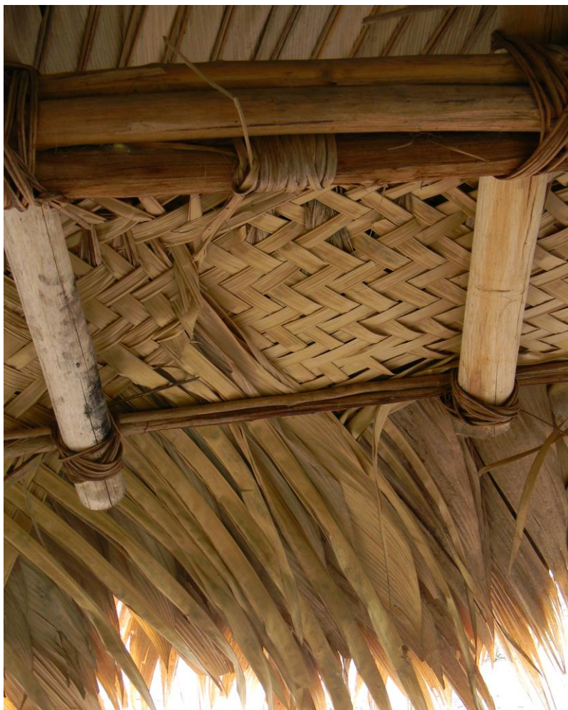
Foto 46 – Detalhe interno da parte inferior do telhado da tamiriki “modelo kaxuyana”
