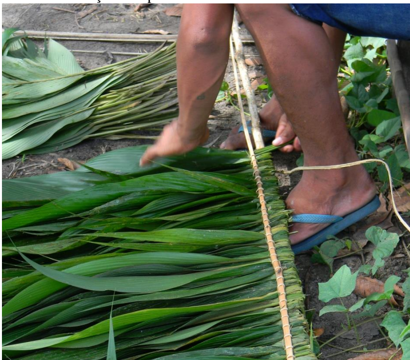
Foto 26 – Trançando a palha antes de colocá-la no telhado
