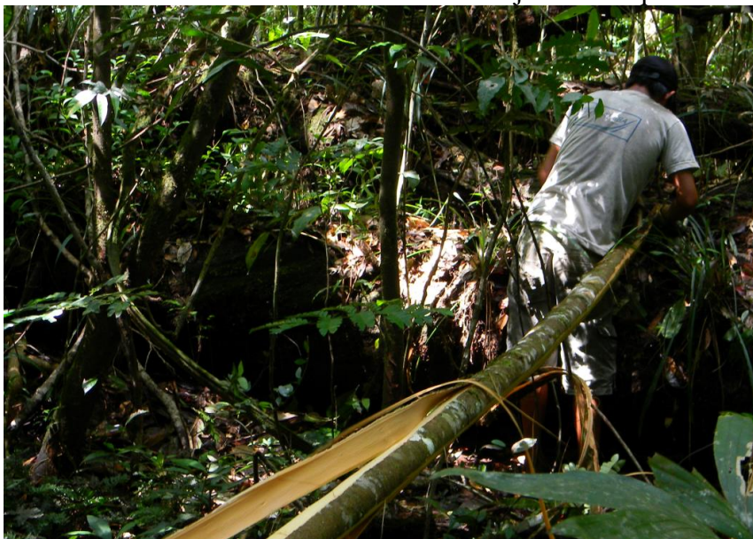
Foto 31 – Extraíndo a entrecasca da madeira já cortada que será usada como esteio lateral
