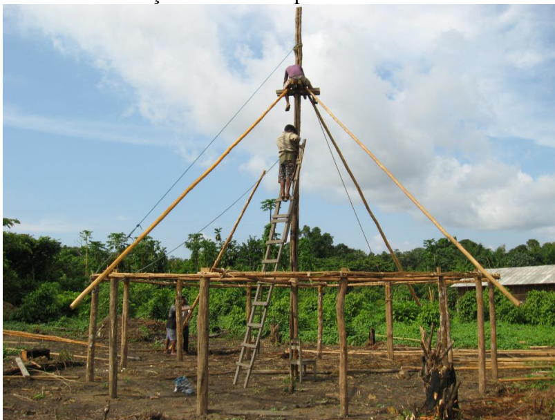
Foto 38 – Instalação dos caibros primários na tamiriki “modelo kaxuyana”
