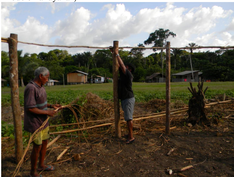
Foto 34 – Amarrando o frechal nos esteios laterais cortados em “L” com cipó ( tamiriki , “modelo kaxuyana”)
