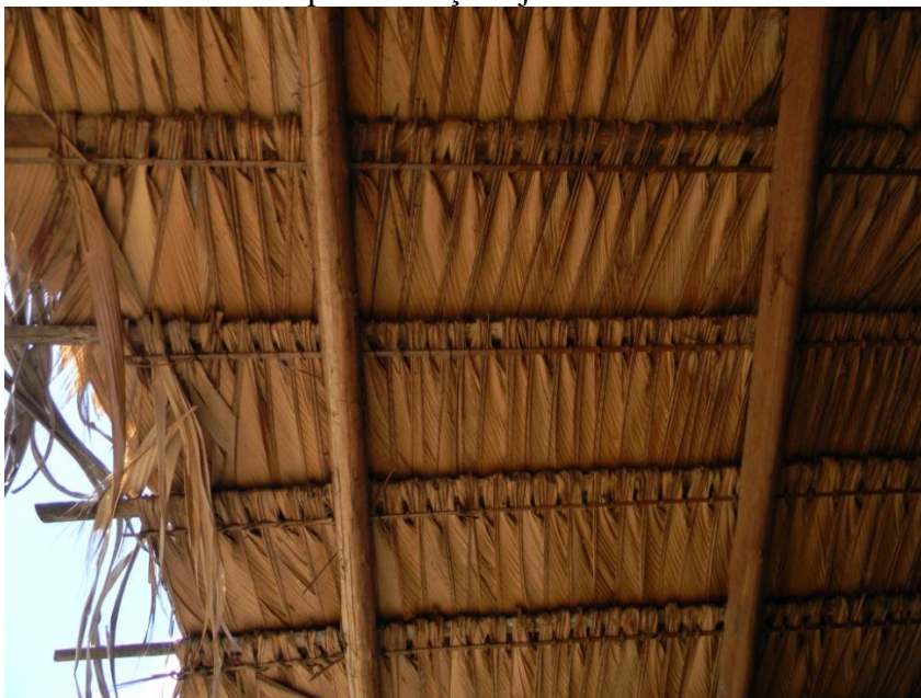
Foto 27 – Detalhe da palha trançada já no telhado
