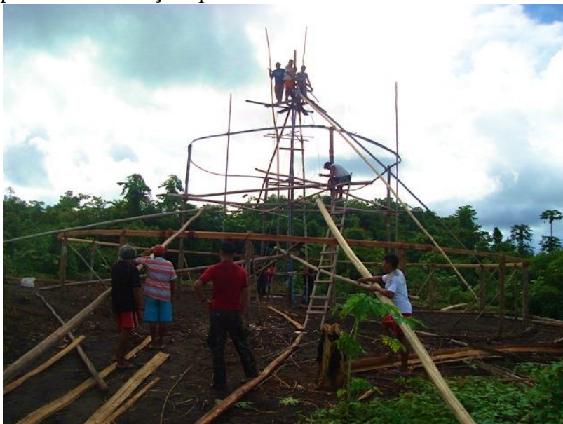
Foto 39 – Vista da estrutura provisória e amarração dos caibros primários. Também é possível ver a terça superior na tamiriki “modelo waiwai”
