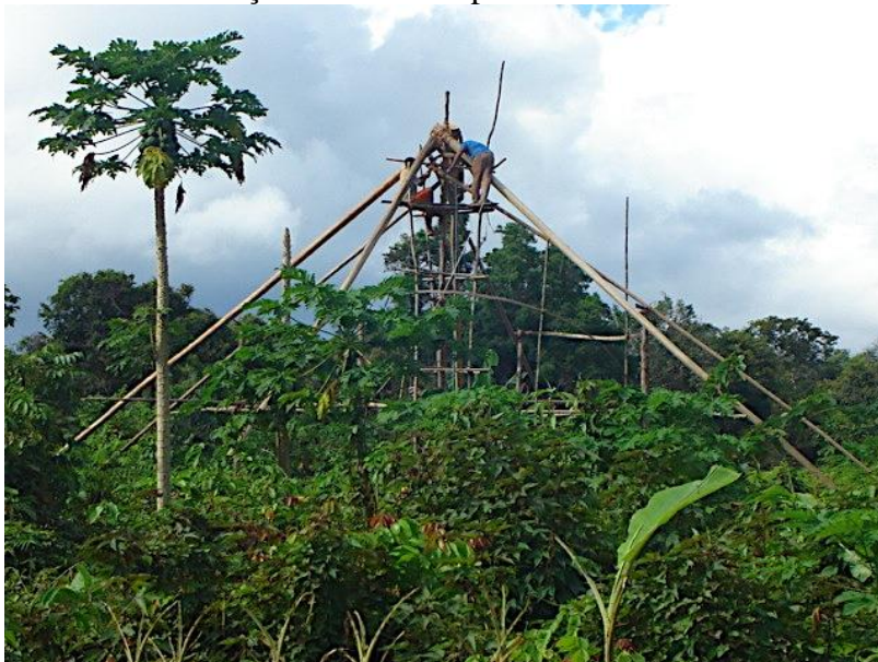
Foto 40 – Colocação dos caibros primários na tamiriki “modelo waiwai”
