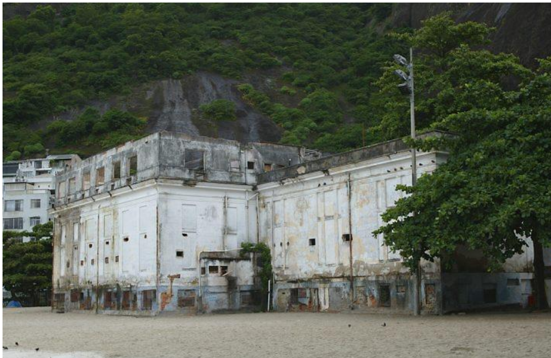
FIGURA 16: Prédio do Cassino da Urca, antes do início das obras realizadas pelo IED. Fonte: Agência O Globo
