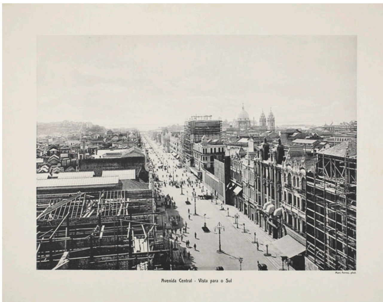
Figura 23: Construção da Avenida Central, vista para o sul
