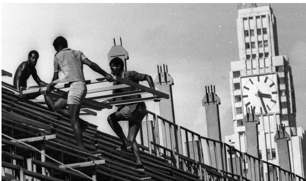
Figura 5: Montagem das arquibancadas – Av. Presidente Vargas, 1976.
