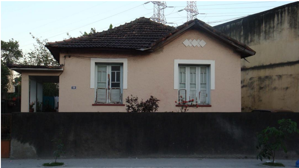
Fig.62 – Foto de residência no bairro do Mutondo. Segundo os autores de Arquitetura no Brasil de Dom João VI a Deodoro , após meados da década de 1870, construções residenciais identificadas como chalés, inspiradas pela literatura romântica europeia foram erigidas no Rio de Janeiro. O custo dessas construções barateou o empreendimento residencial e adequou-se às demandas da crescente população urbana. As fachadas de tais casas se caracterizavam pela apresentação do frontão triangular com decoração em baixo relevo. Tais estilos residenciais podem ser vistos em bairros populares e periféricos como São Cristóvão. Foto: Regilan Deusamar em 22 de abril de 2011.
