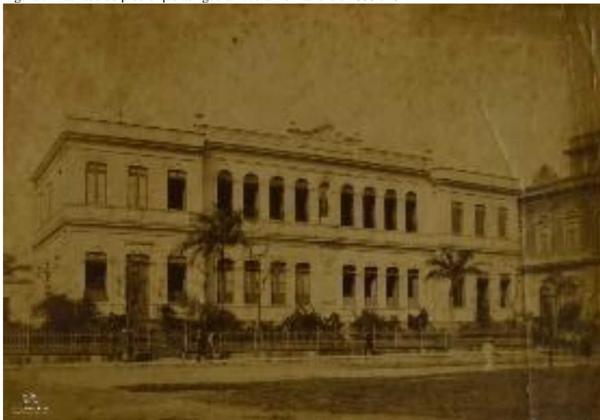
Figura 7- Fachada do prédio que abrigou a Escola Normal entre 1888 e 1914
