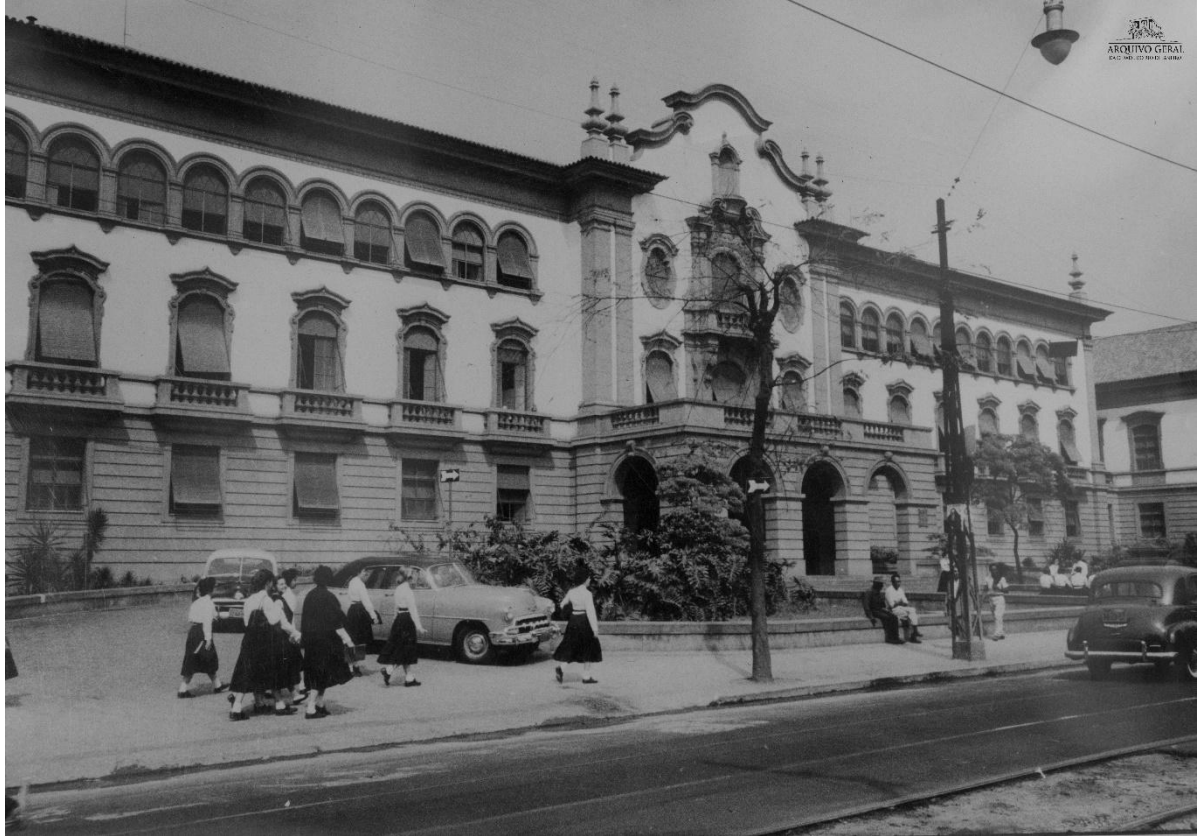
Figura 9- Fachada da sede da Escola Normal, inaugurada em 1930.
