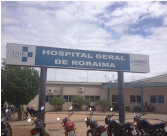
Figura 08. Foto do Hospital Geral de Roraima.
