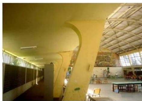
Vista interna do ginásio da Escola-Parque
