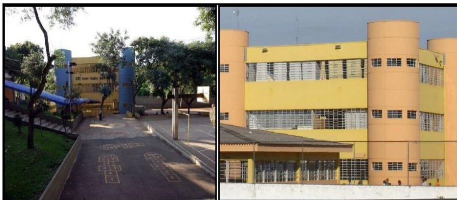
Figura 08 - Estrutura física do prédio dos CEIs – complexo II.
