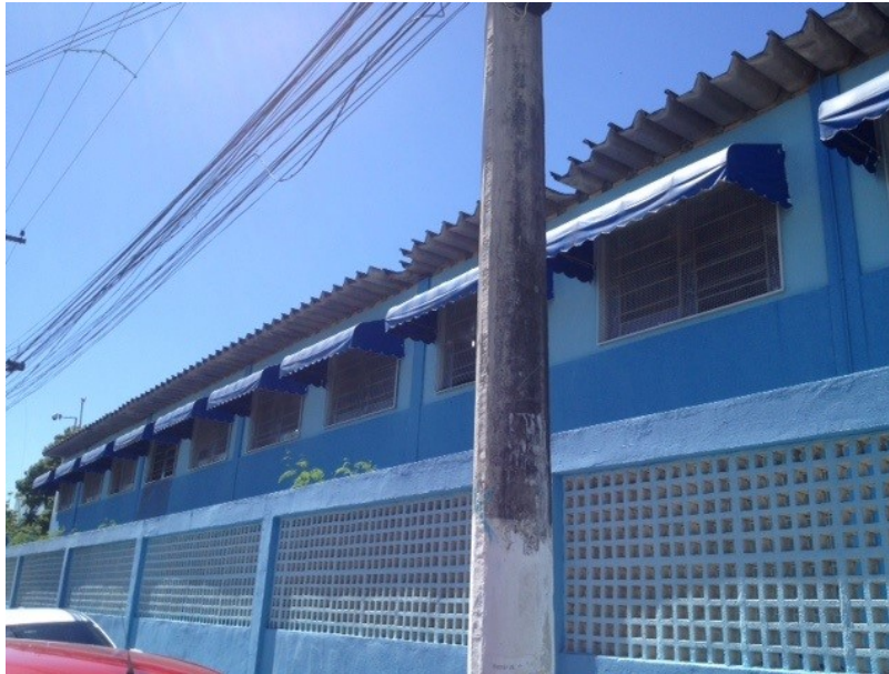
Figura 3: Fachada da escola
