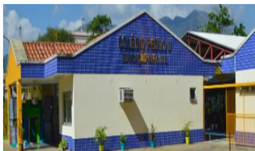
Foto 5 – Fachada do CREIR
