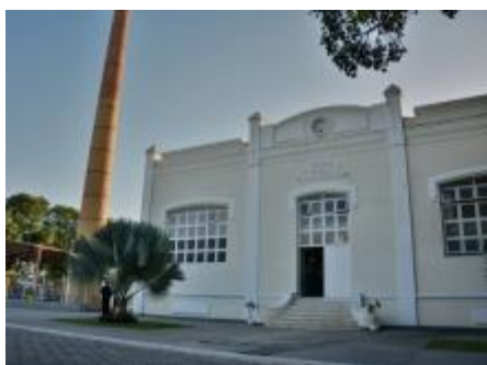
Foto 1 – Fachada do prédio
