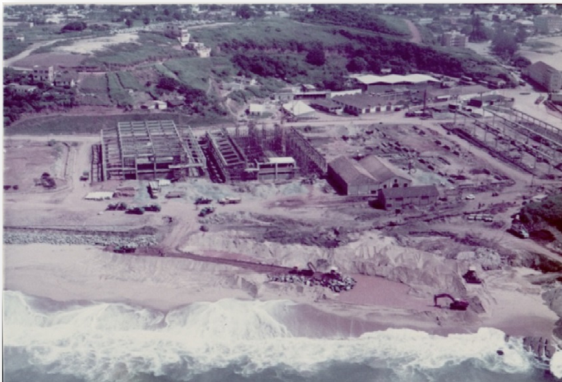
Figura 28 - Obras para instalação da Petrobras em meados dos anos 1970, onde se pode ver ao lado os velhos galpões das Oficinas Ferroviárias de Imbetiba
