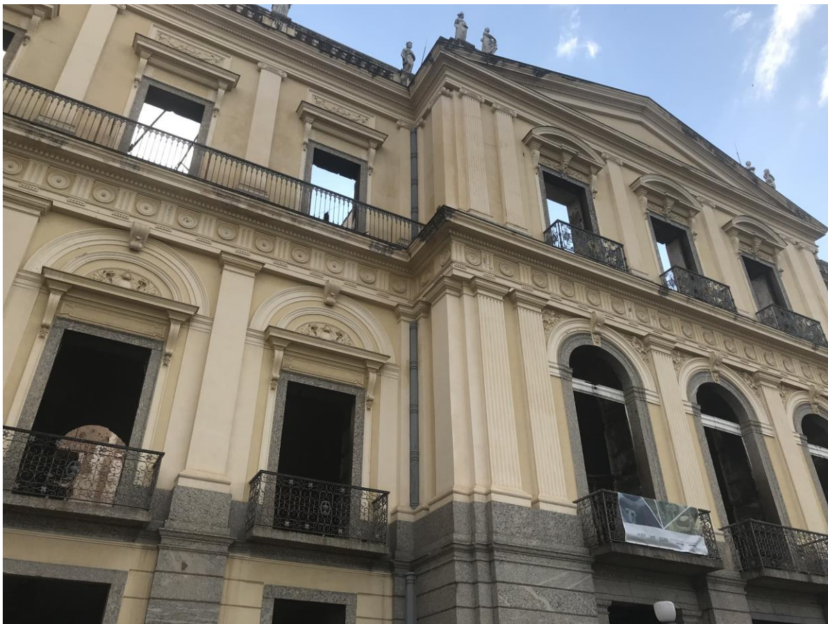
Figura 13: Fachada do Museu Nacional após o incêndio. Foto: Vera Mangas.
