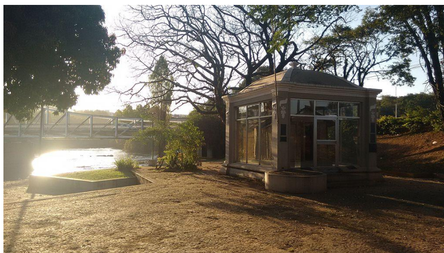
Figura 2 – Cabana onde Euclides da Cunha escreveu parte de Os Sertões , enquanto supervisionava a obra da ponte metálica sobre o Rio Pardo – SP.
