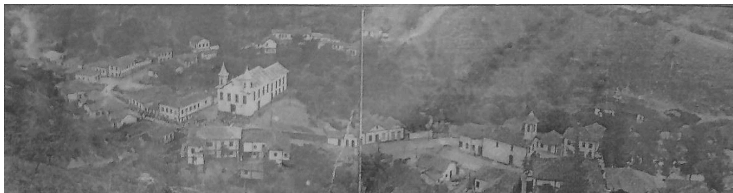
Imagem 7 – Panorâmica da sede do distrito de São Sebastião do Rio Preto em 1955, com suas duas igrejas: a "de cima", de São Sebastião, e a "de baixo", do Rosário. Fotografia de autor desconhecido.
