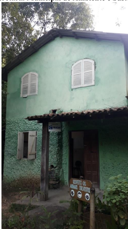
Figura 23: Base da Secretaria Municipal de Ambiente e Sustentabilidade de Macaé, no Sana
