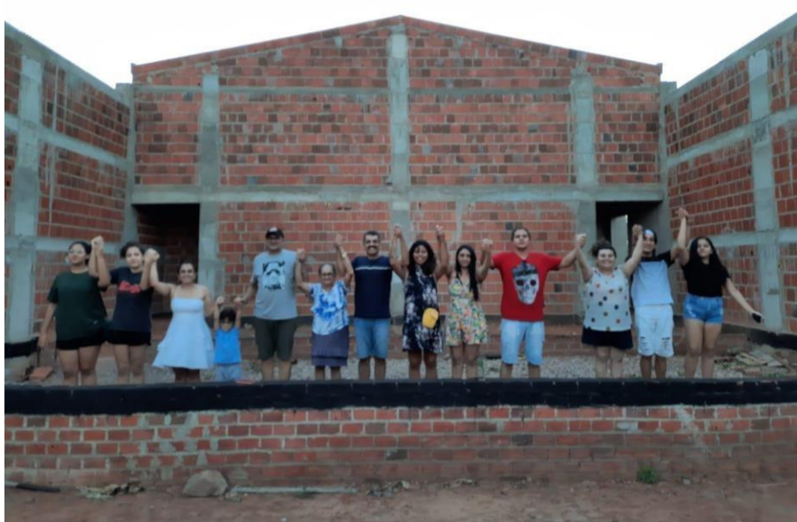
Imagem 3: Teatro Clô Cavalcante em Construção. Fonte acervo pessoal, Banabuiú, 2021.
