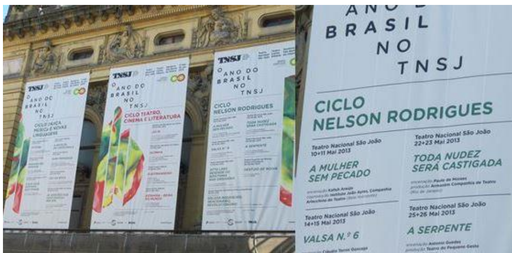
Figura 35 - Fachada do Teatro Nacional São João – Cidade do Porto. Foto: Acervo pessoal do autor.
