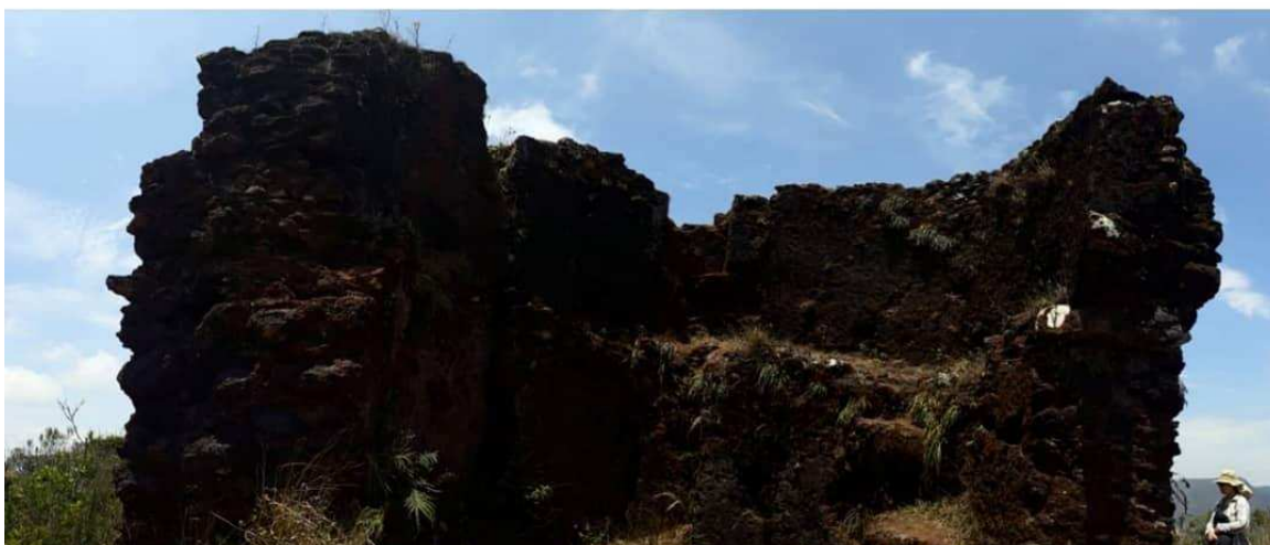
Figura 9 - Estrutura remanescente de moinho, localizada no PNMMQ.
