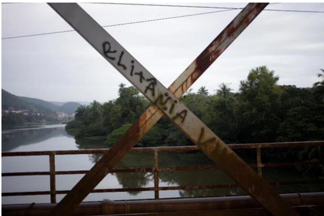
Figura 11: “Elitânia Vive” pichada na Ponte Dom Pedro II que liga as cidades de Cachoeira e São Félix sobre o Rio Paraguaçu no Recôncavo Baiano. Foto: Rodolfo de Jesus (2021)
