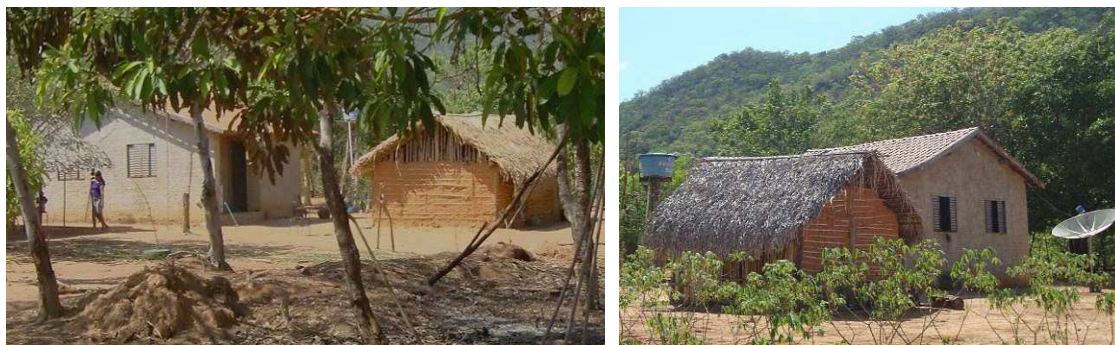
Figura 24 – Casa original de taipa ao lado da casa de alvenaria
