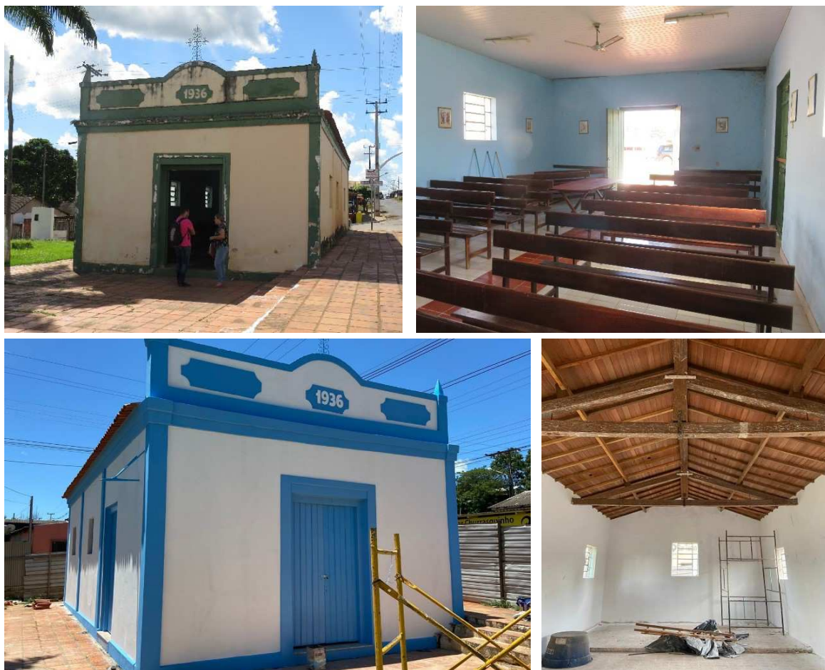
Figura 34 – Igrejinha de Santa Cruz em fotos de antes e depois das obras de conservação
