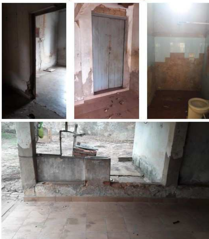
Figura 8 – Vistas internas da Casa Borges
