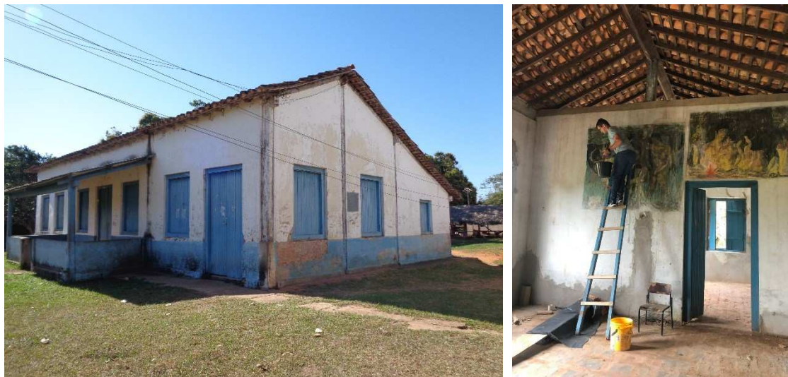
Figura 13 – Fachadas de uma das Casas de Rondon na aldeia Umutina, remanescentes do Posto Fraternidade Indígena / Restauração de pintura mural no interior da mesma casa
