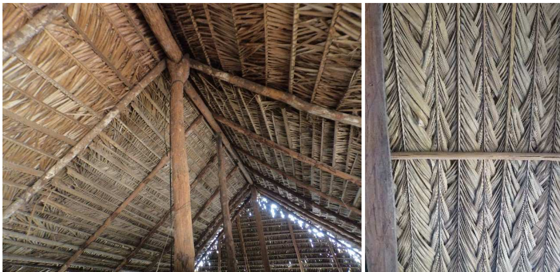
Figura 17 – Cobertura com as folhas superpostas na horizontal ou trançadas
