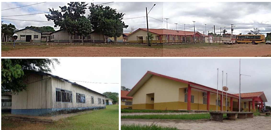
Figura 26 – Os dois edifícios da Escola Estadual Paulo Freire em 2015, à esquerda a de madeira, já abandonada, e à direita a escola nova
