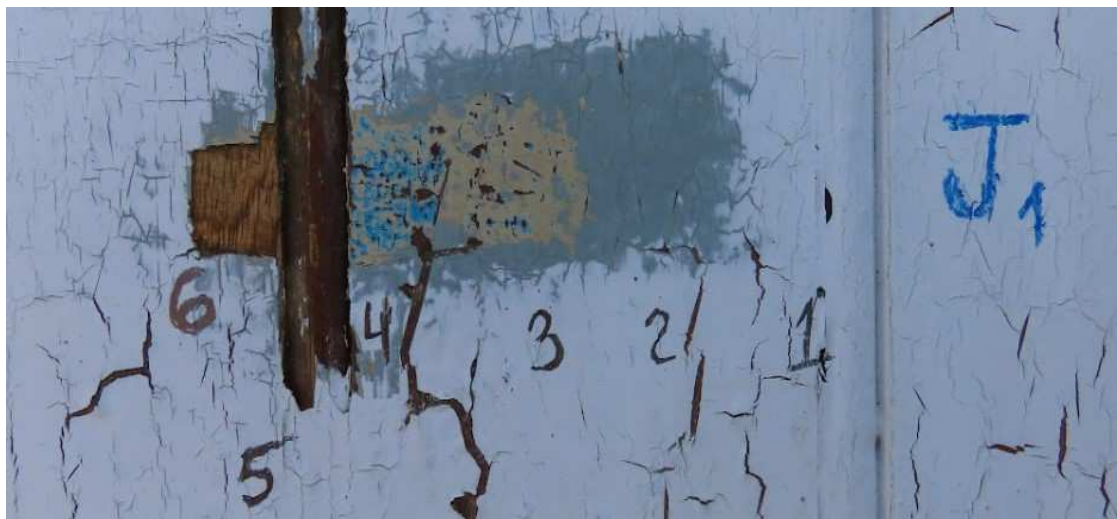
Figura 54: Prospecção das camadas de tinta na folha das janelas
