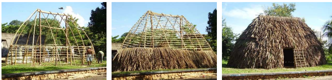
Figura 30 – Casa Bakairi em construção no Museu Rondon, UFMT
