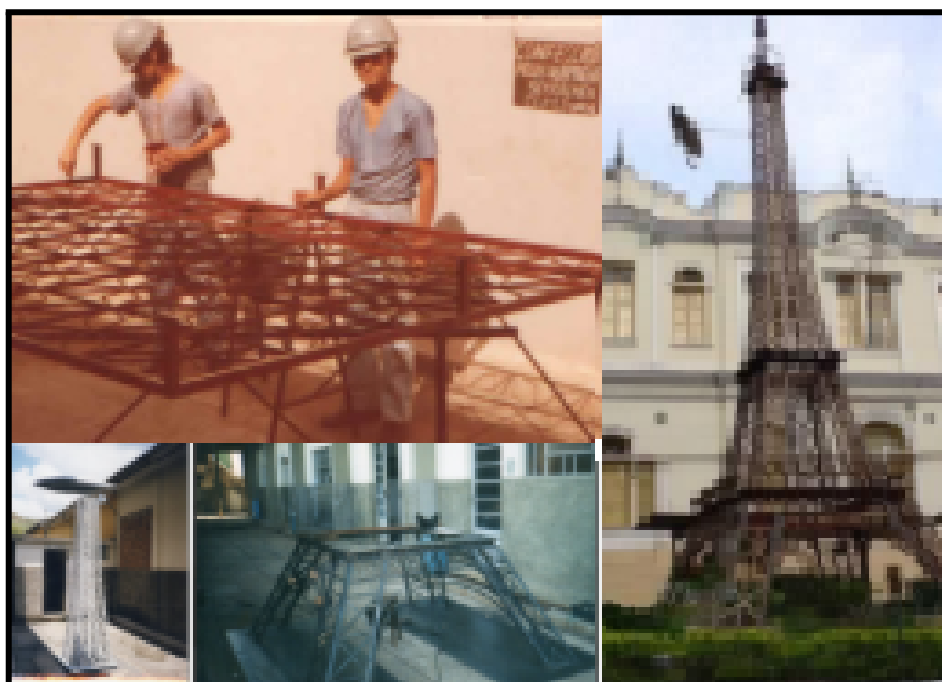
Figura 52 - Partes da Torre Eiffel produzidas com Máquina Calandra
