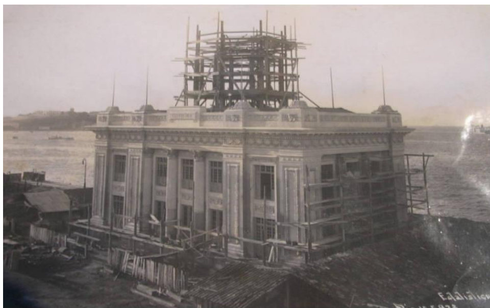
Figura 22 - Prédio do CCMS
