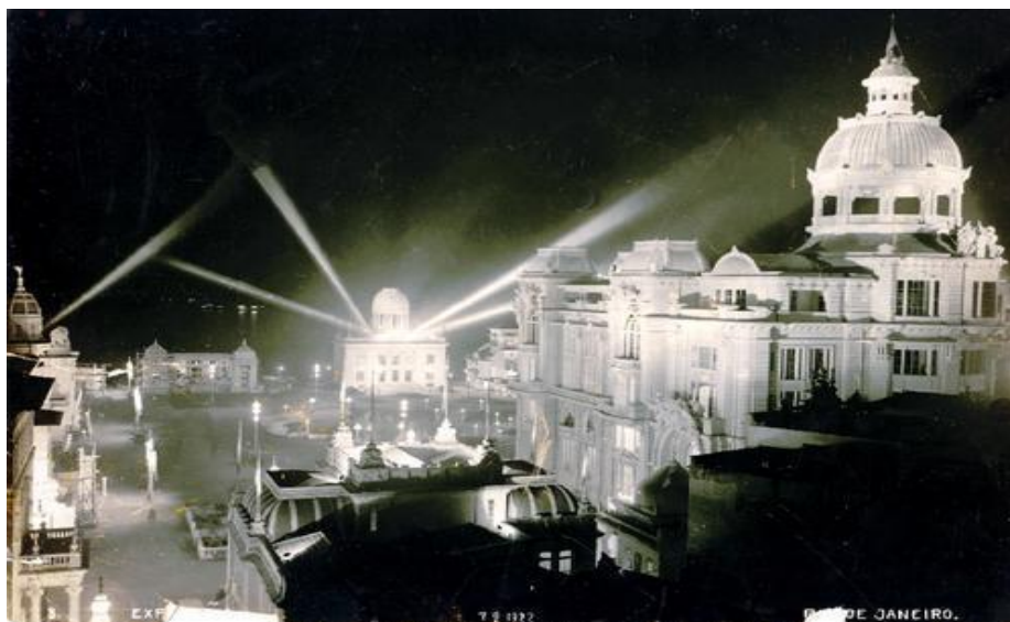
Figura 3 - Pavilhão de Estatística, no centro ao fundo, bem iluminado
