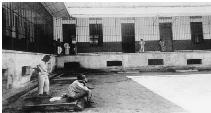
Figura 78 - Hospital Juliano Moreira – Belém
