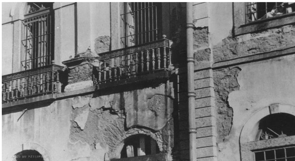
Figura 56 - Hospício Nacional de Alienados - Prédio degradado
