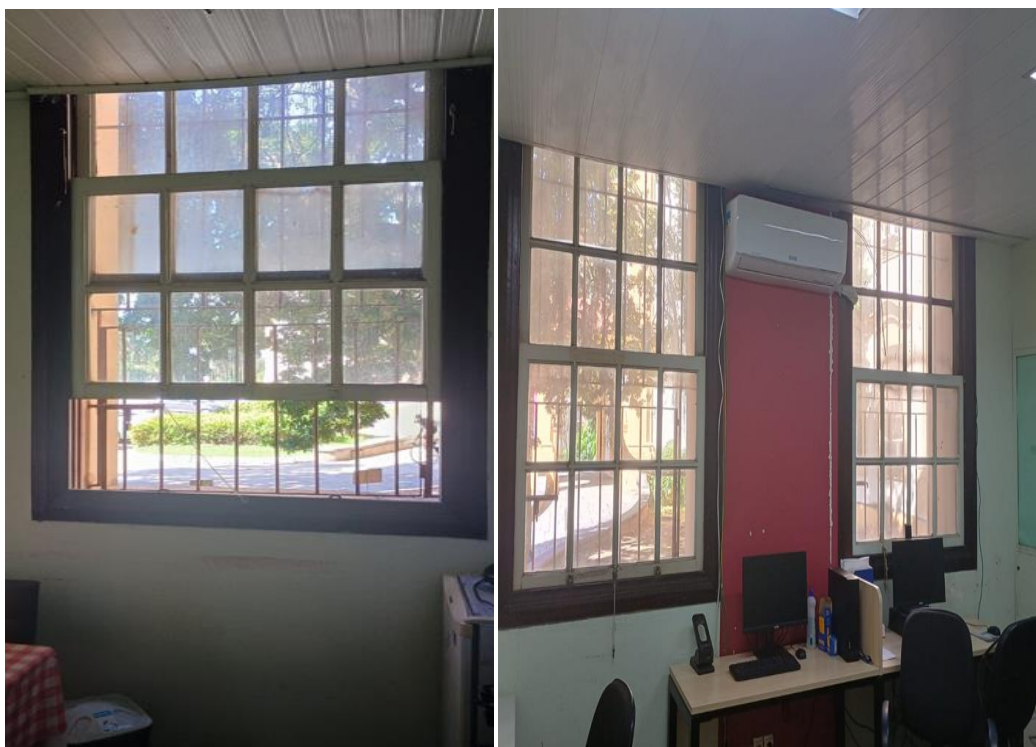
FIGURA 11 – SAÍDAS DE EMERGÊNCIA DA SAPG-UFRRJ
